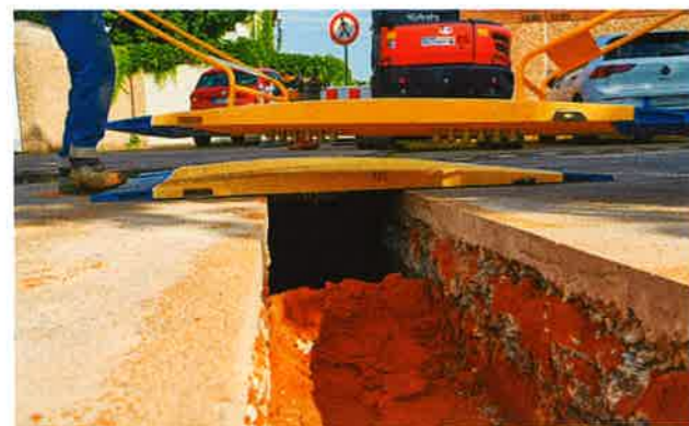
Bild 3: Verlegung der RoadPlate 23/05
