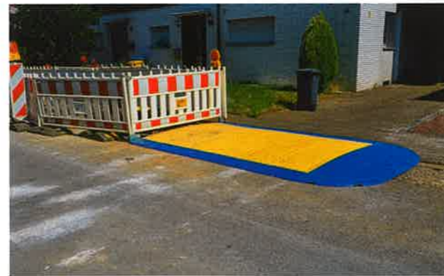
Bild 2: Einfahrt nach dem Austausch der Stahlplatte durch die RoadPlate 23/05
