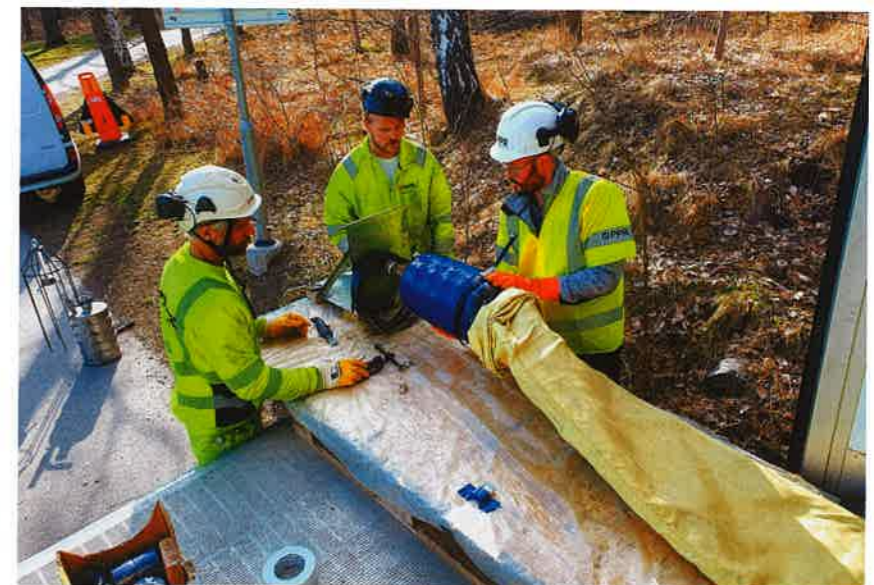
Schlauchlining für zu sanierende Fernwärmenetze: CarboSeal
