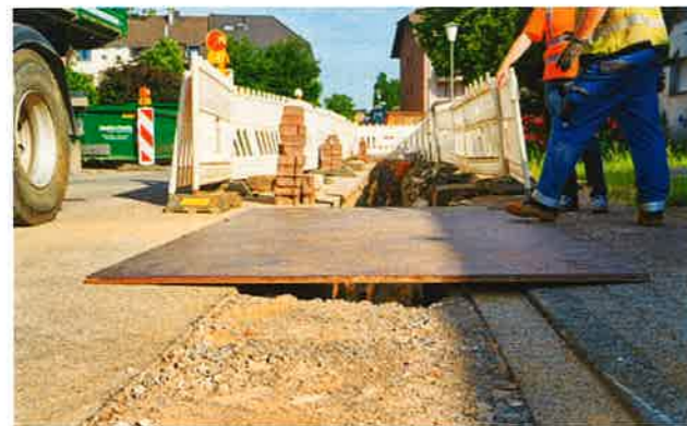
Bild 1: Grundstückszufahrt mit einer 4,5 cm dicken Stahlplatte abgedeckt
