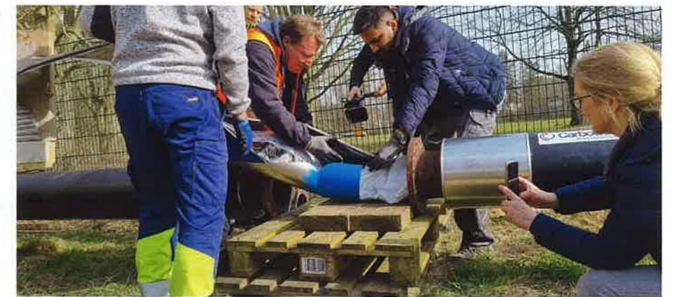
Beginn des Linereinzuges | Foto: PPR Deutschland
