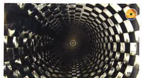
Inspektionsfoto nach abgeschlossener Aushärtung des Liners | Foto: PPR Deutschland
