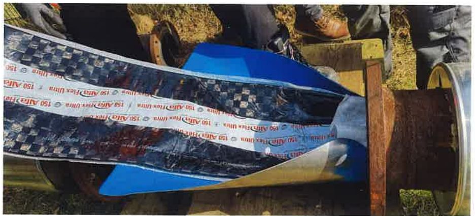
Der Carbonfaserliner während des Einzuges. | Foto: PPR Deutschland
