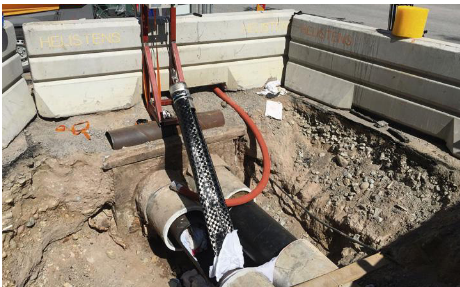
Einzug des Liners auf einer Pilotbaustelle | Fotos: PPR
